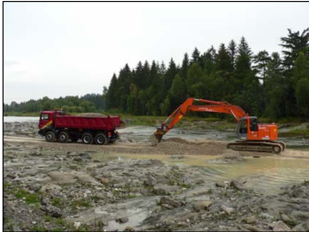
Abb. 9 Bau einer Zufahrtsrampe
