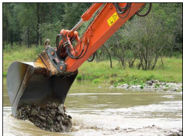
Abb. 15 Wiedereinbringung des gelockerten Materials
