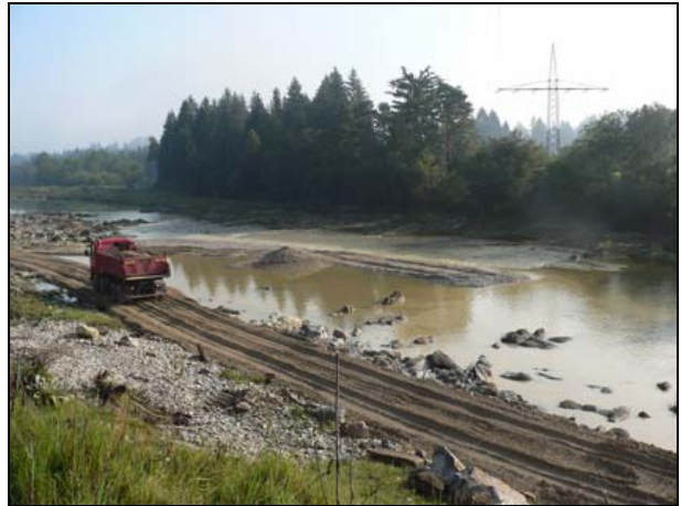
Abb. 10 Anlegen einer uferparallelen Baustraße
