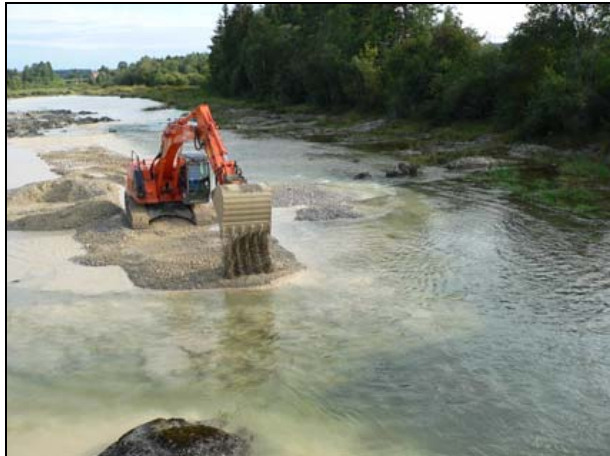
Abb. 11 Einbringung des Kiesel
